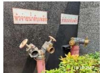
หัวรับน้ำดับเพลิงและหัวจ่ายน้ำดับเพลิง
